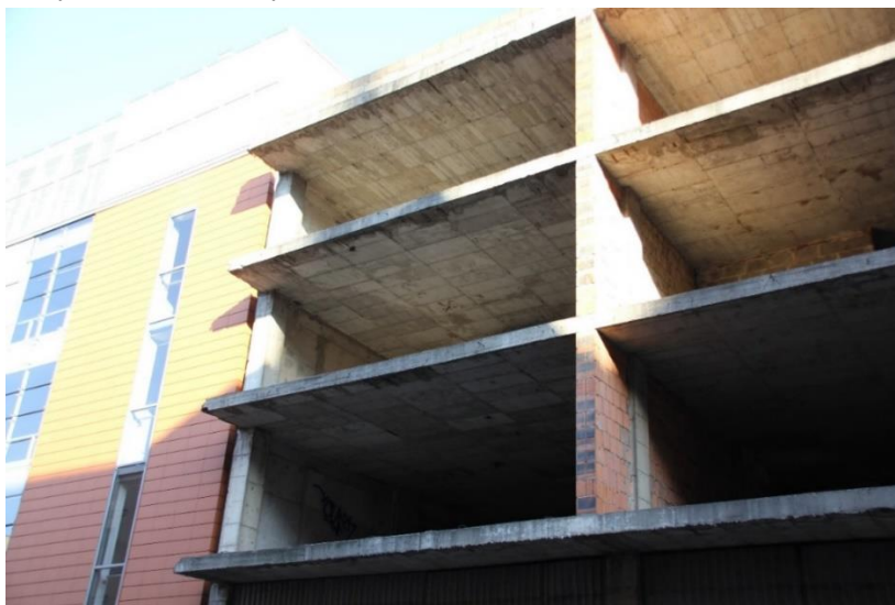
Rysunek 1. Przykład konstrukcji płytowo-słupowej – ustrój płytowo-słupowy z usztywniającą ścianą szczytową (widoczne na zdjęciu ściany z elementów ceramicznych zostały wykonane po przygotowaniu monolitycznej konstrukcji w związku z czym stanowią jedynie obciążenie konstrukcji) [materiały własne]
